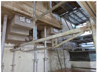
Die neu gegossenen Konsolen mit Blick auf den sanierten äußeren Ringanker.
